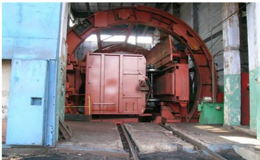
Разгрузка полувагона на вагоноопрокидывателе
